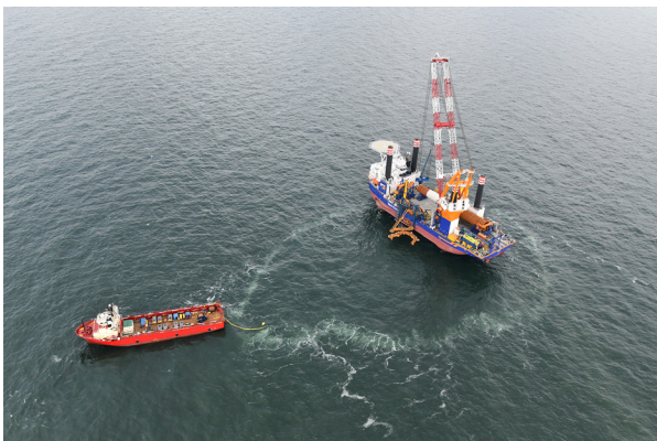
Figuur 57. Gebruik van een bellengordijn tijdens de bouwfase van windmolenpark 'Northor' in 2018.
